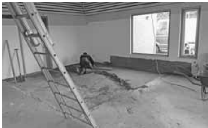
In de ruimte waar vroeger de jeugdsoos zat, moet de zitkuil dichtgemaakt worden om vloerverwarming aan te kunnen leggen.
